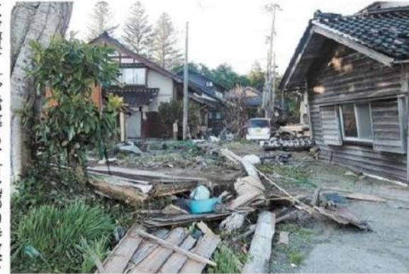
津波を受けるなどして倒壊した家屋 11日、石川県珠洲市三崎町
